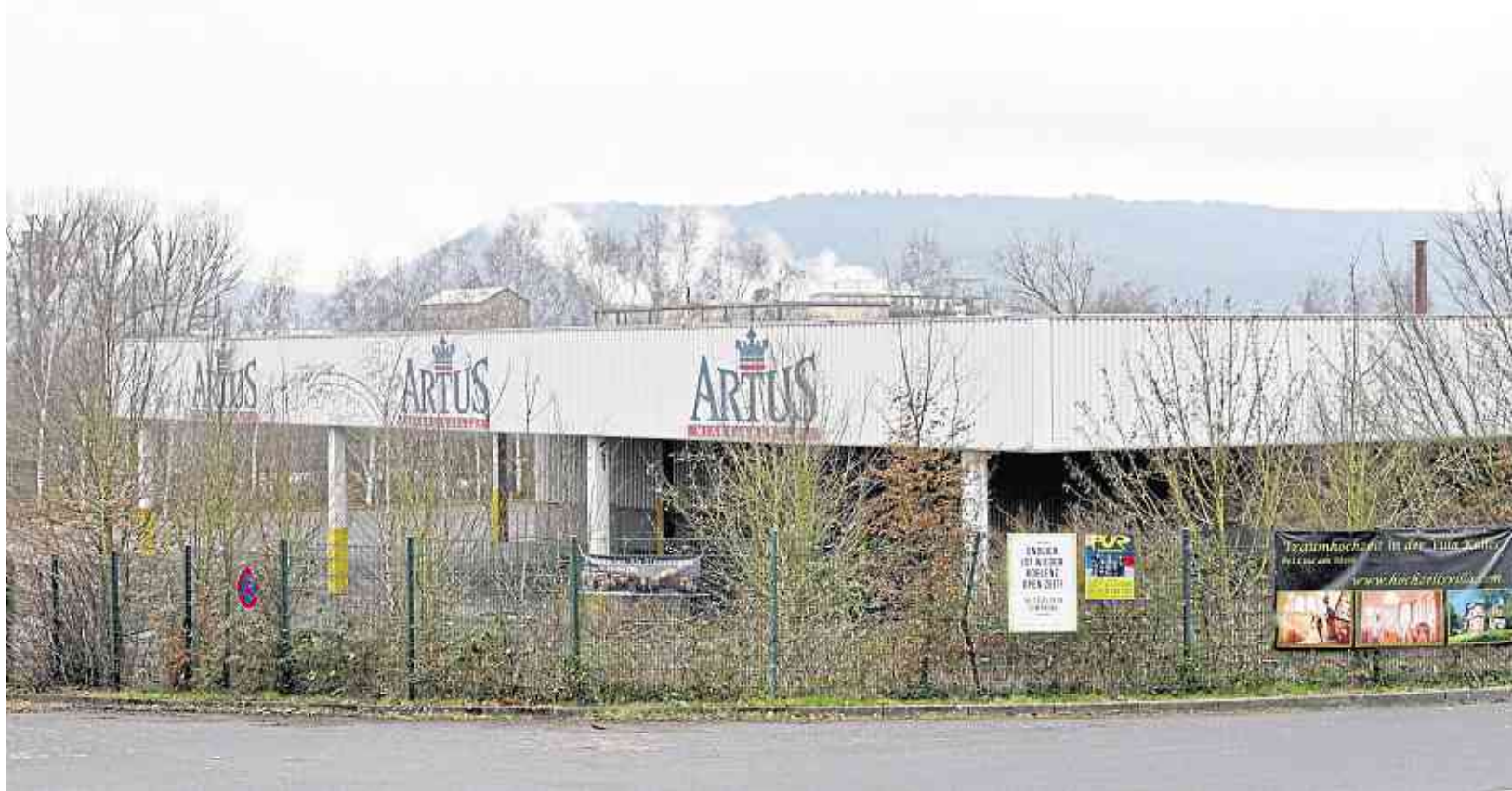
Noch im ersten Halbjahr sollen nach Angaben von Jennwein Biotechnologie auf dem ehemaligen Artus-Mineralquellen-Gelände in Bad Hönningen die Abrissbagger rollen. Das Unternehmen will dort ein neues Produktionswerk bauen.
